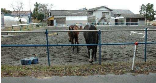
大瀧馬事苑の練習場 後方の倉庫の落ちた屋根が修理されている厩舎は2箇所に分かれるが頑丈な造りで被害はなかった
